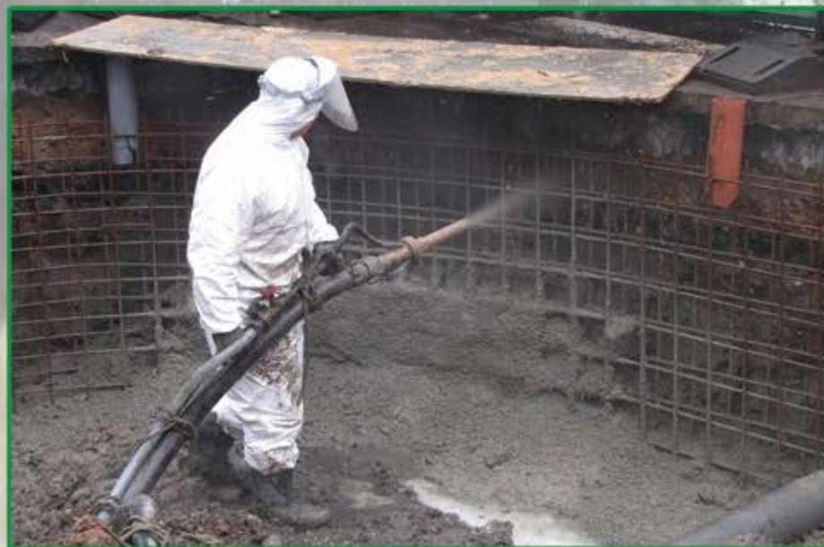
Budowa komór żelbetowych wykonywanych metodą betonu natryskowego
